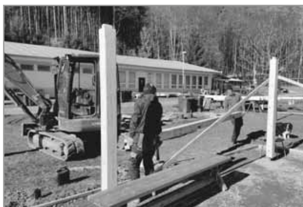
Stavba pergoly a technického zázemí na Kempu
