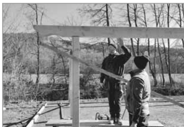
Stavba pergoly a technického zázemí na Kempu
