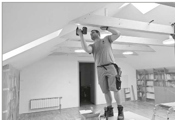
Oprava kleštin na ZŠ
