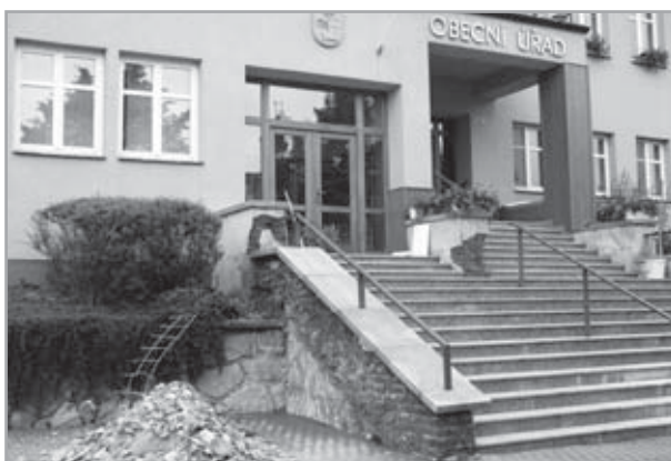
Oprava schodiště u OU
