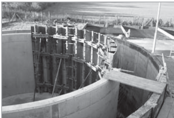
Rekonstrukce čistírny odpadních vod
