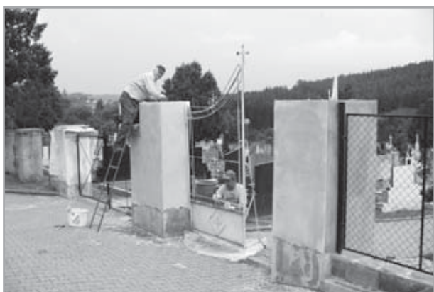
Oprava brány a sloupků na hřbitově
