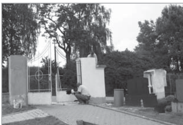
Oprava brány a sloupků na hřbitově
