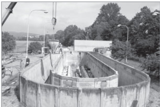
Rekonstrukce čistírny odpadních vod
