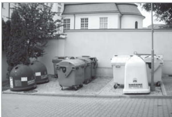
Nově vydlážděná plocha na kontejnery
