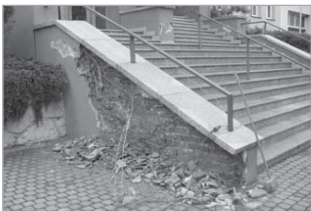
Oprava schodiště u OU
