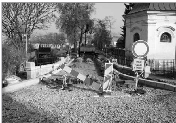
Rekonstrukce barokního mostu
