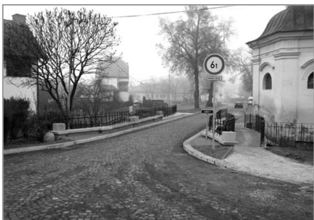
Barokní most po rekonstrukci
