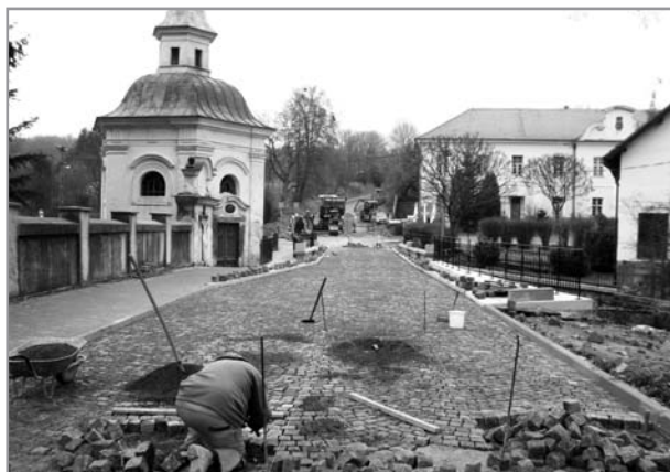
Rekonstrukce barokního mostu
