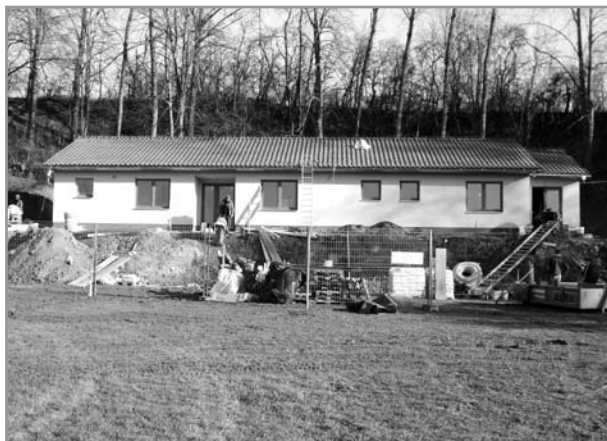
Novostavba šaten na místním hřišti
