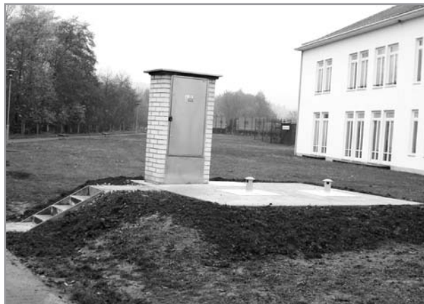
Čerpací stanice (ČS2) u ZŠ po rekonstrukci
