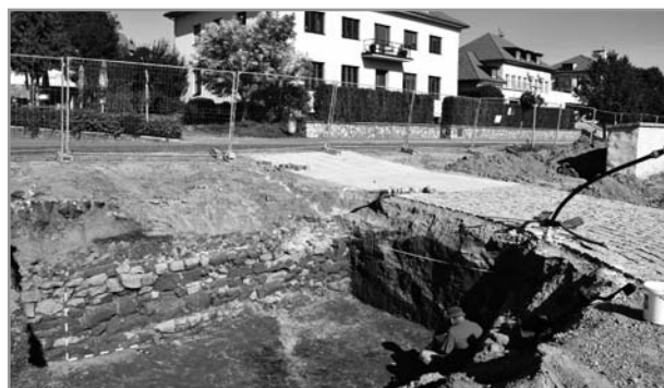
Výkop šachty pro technologii fontány v místě nově budovaného vstupu do areálu Velehradu. Celkový pohled od západu na odkrytý průběh severní ohradní zdi (Foto Z. Schenk)
