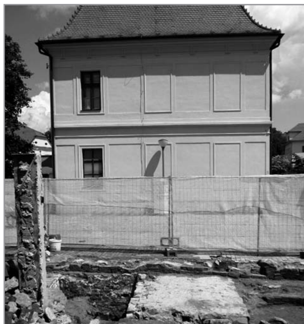
Pohled na odkrytý průběh východní obvodové zdi hranolové věže. V pozadí jižní průčelí objektu Mateřské školy (Foto Z. Schenk 2014)
