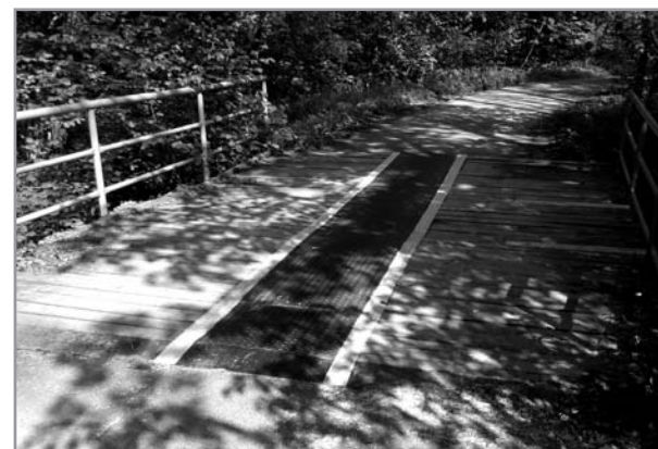
Provizorní oprava mostku cyklostezky na Salaš.
