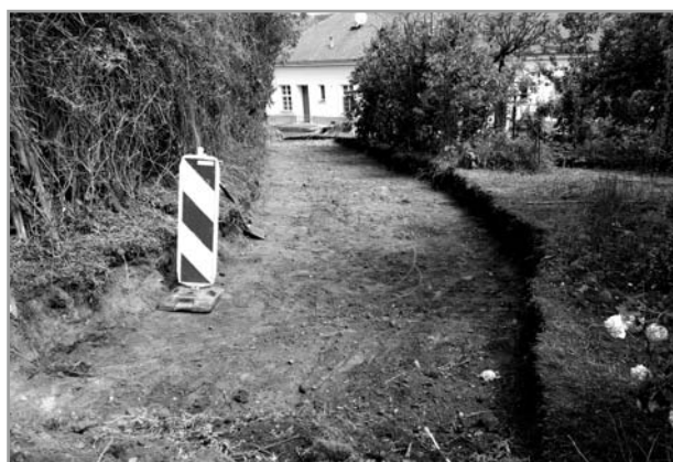
Stavba cesty u č.p. 2
