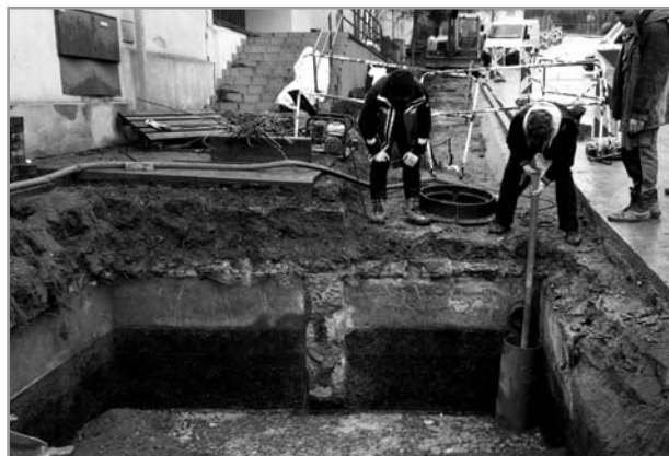
Stavba nového chodníku podél restaurace Vega
