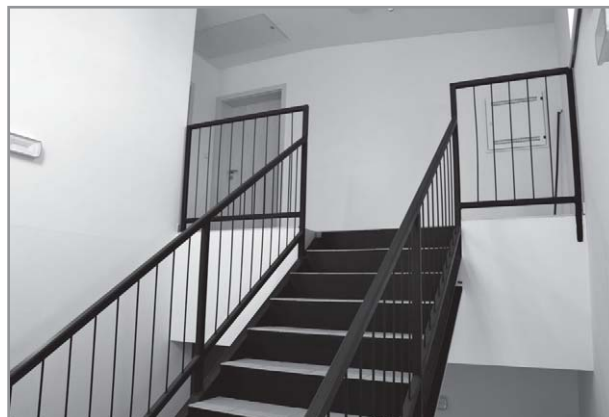
Schodiště do nových obecních bytů
