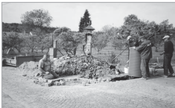
Oprava kanalizace na Modřanské ulici.
