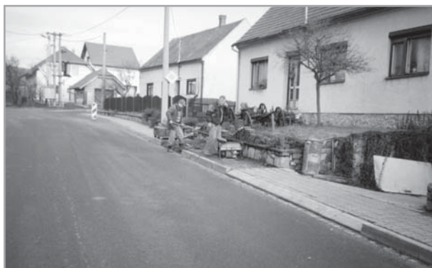
Zahájení - přechod pro chodce - ul. Salašská.
